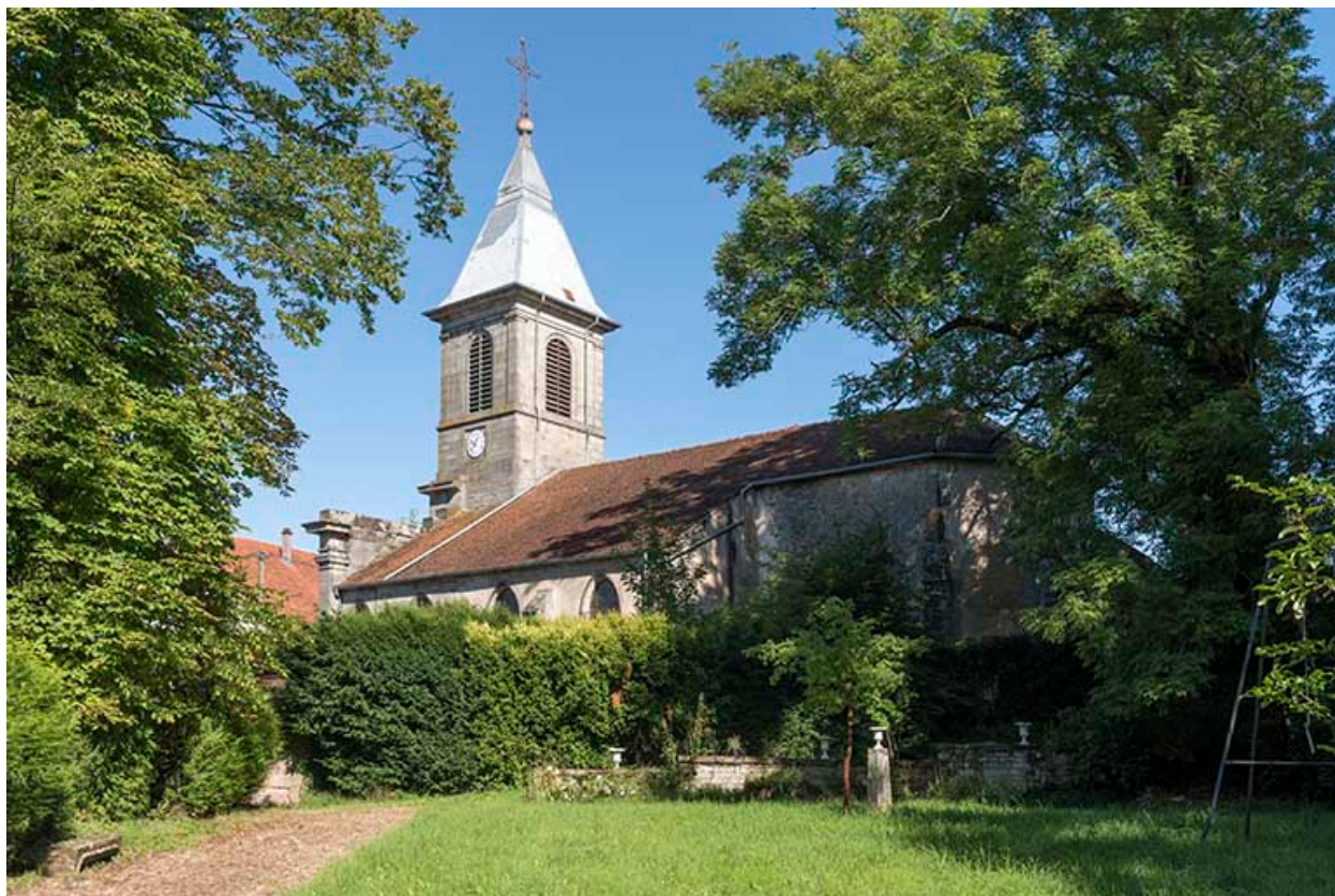
Vue de trois-quart sud-est.
