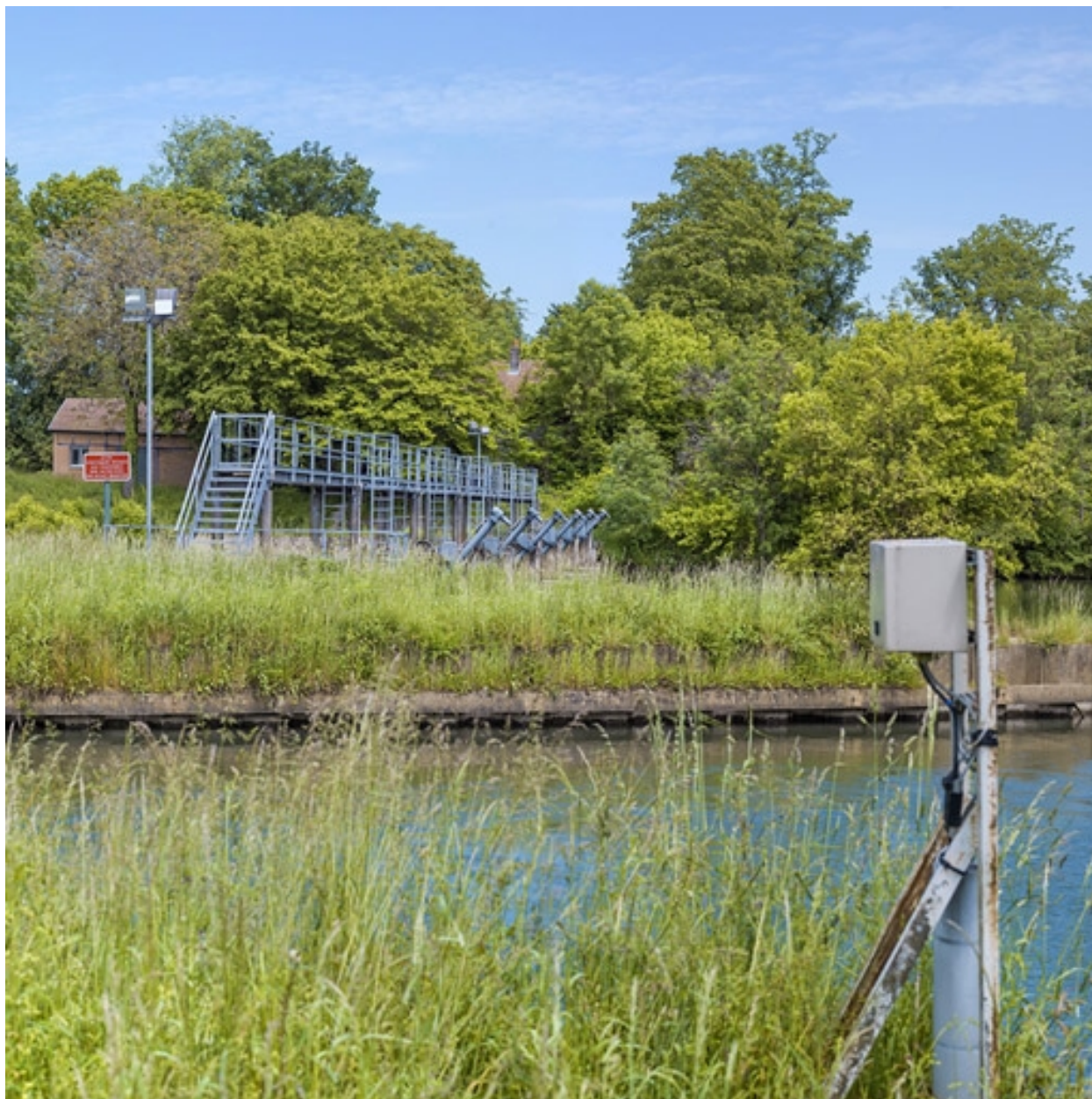
Les vérins du barrage.
