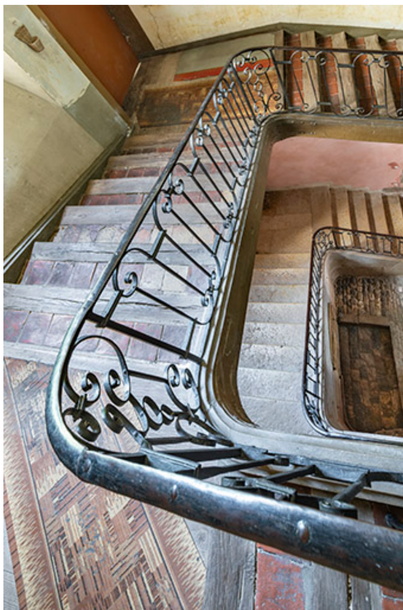
Vue plongeante sur la cage d'escalier.
