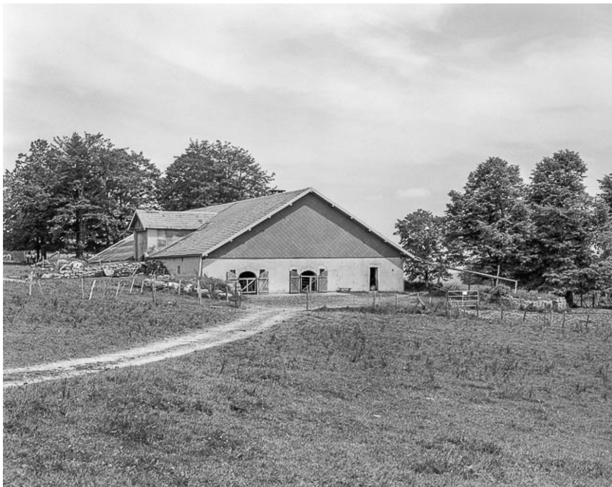
Façades postérieure et latérale gauche.
