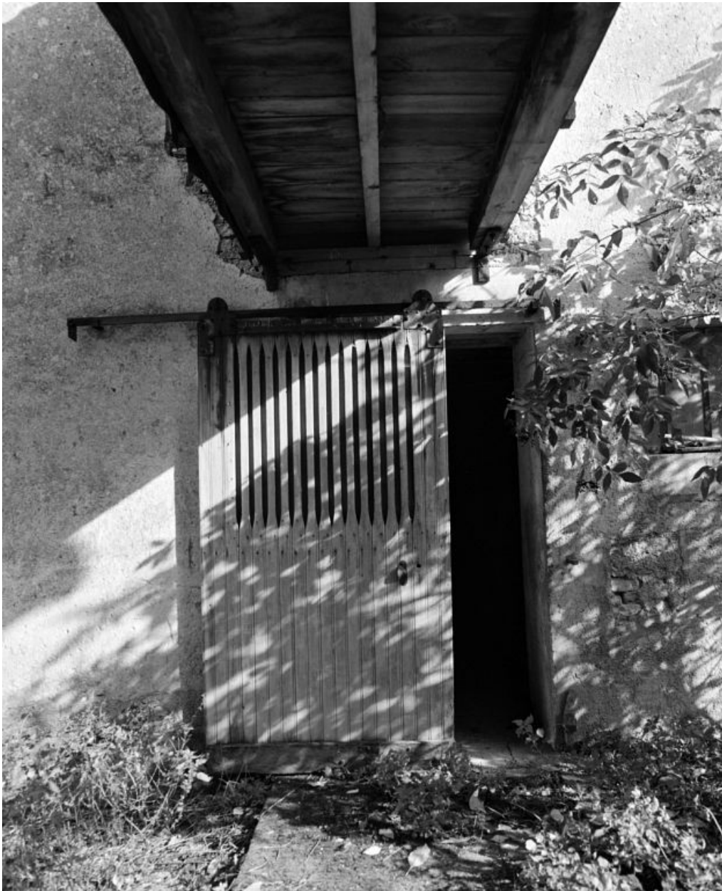
Façade postérieure de la grange. Détail de la porte des écuries.
