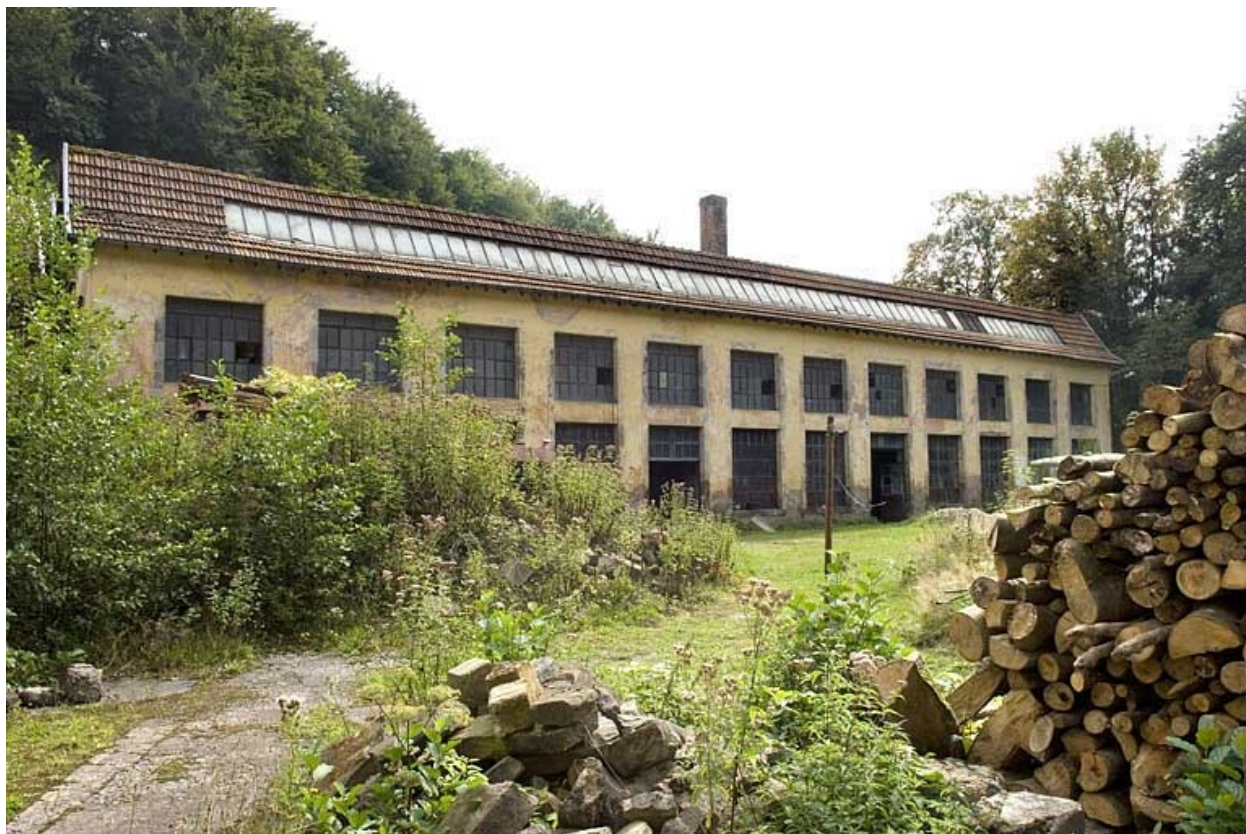
Façade occidentale de l'atelier de fabrication.
