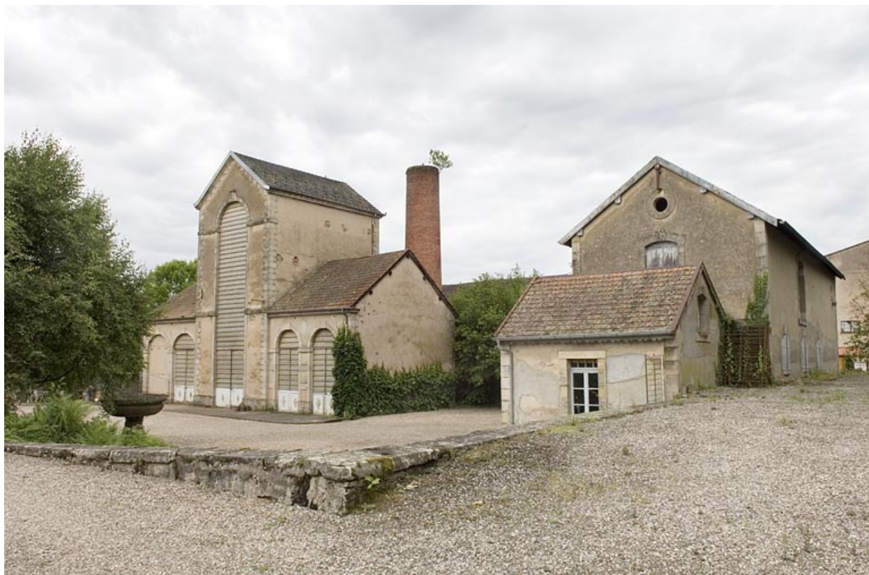
Bâtiment de rectification, bureau et entrepôt industriel.
