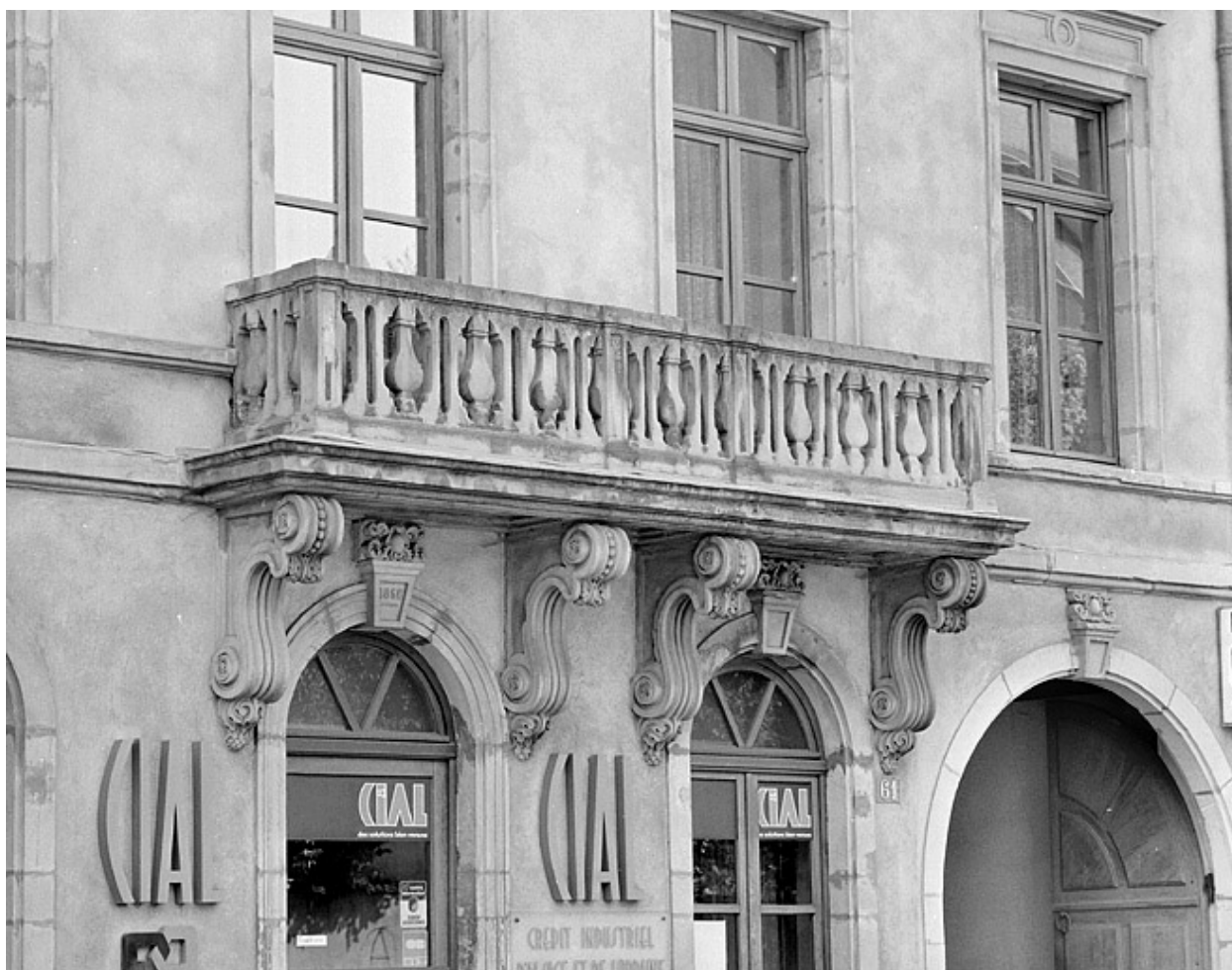
Façade sur rue. Détail du balcon.
