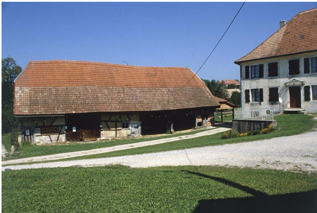
Remise, grange et écurie depuis le sud.
