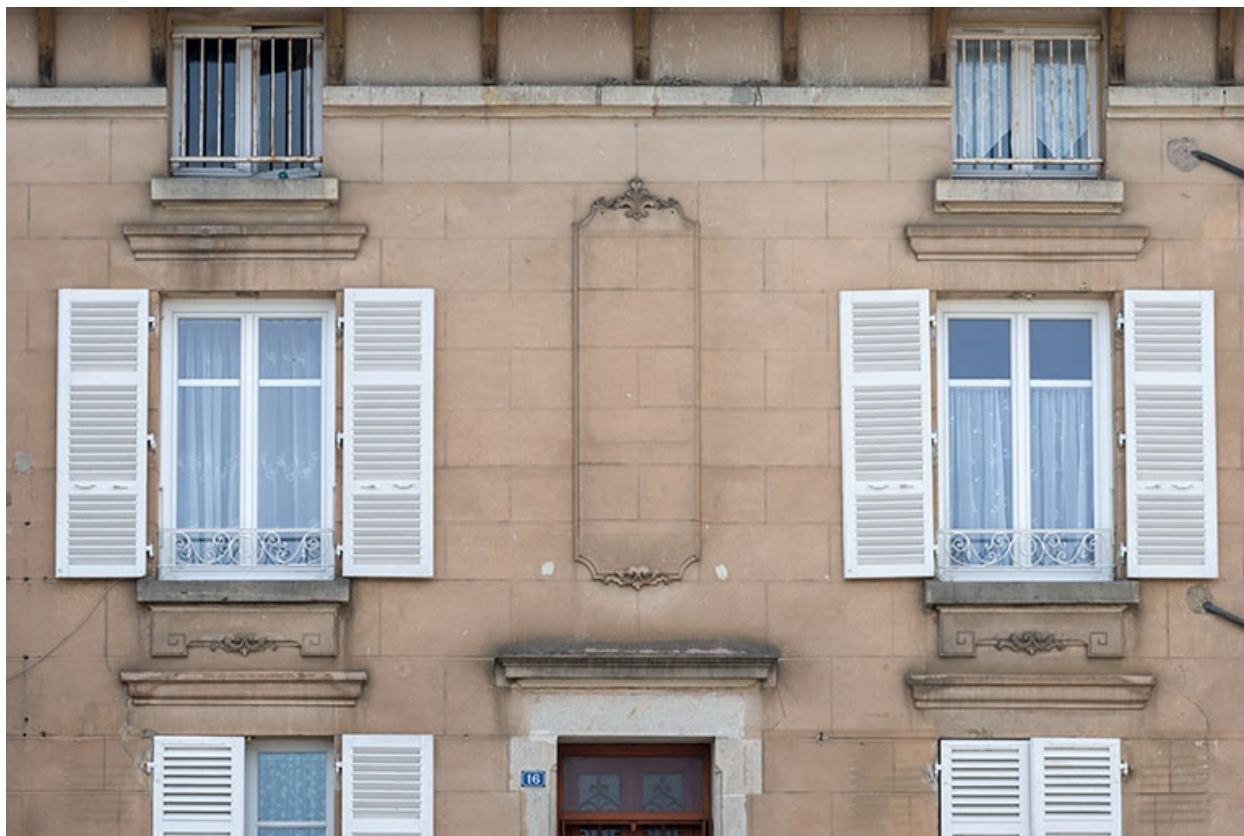
Détail de la façade sur rue.
