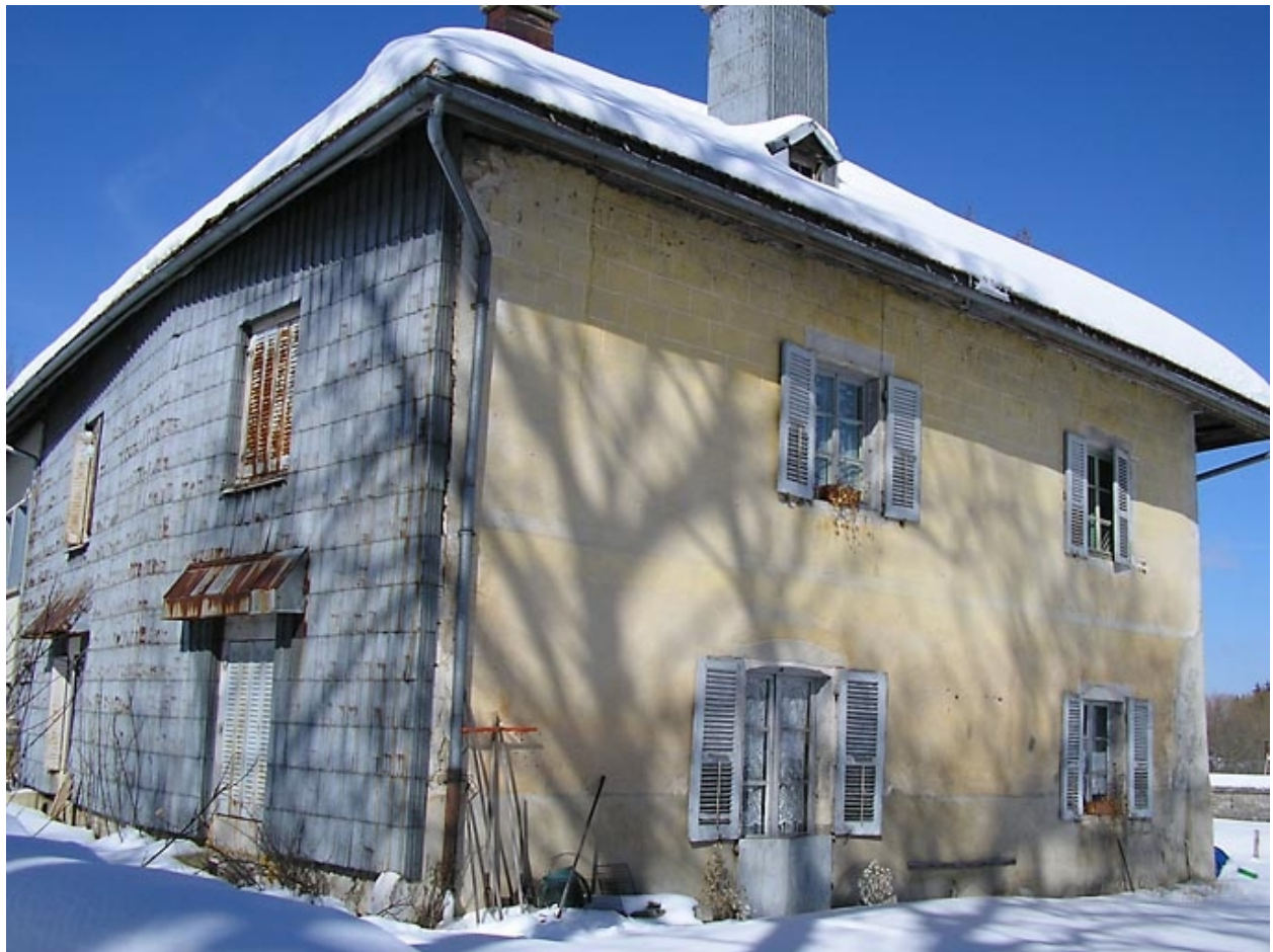
Presbytère, salle paroissiale (actuellement maison).
