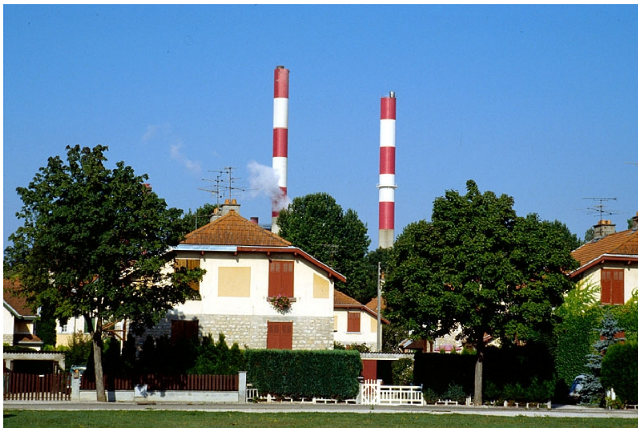
Maison d'ouvriers de type 10A, 10, 12 rue Carnot.
