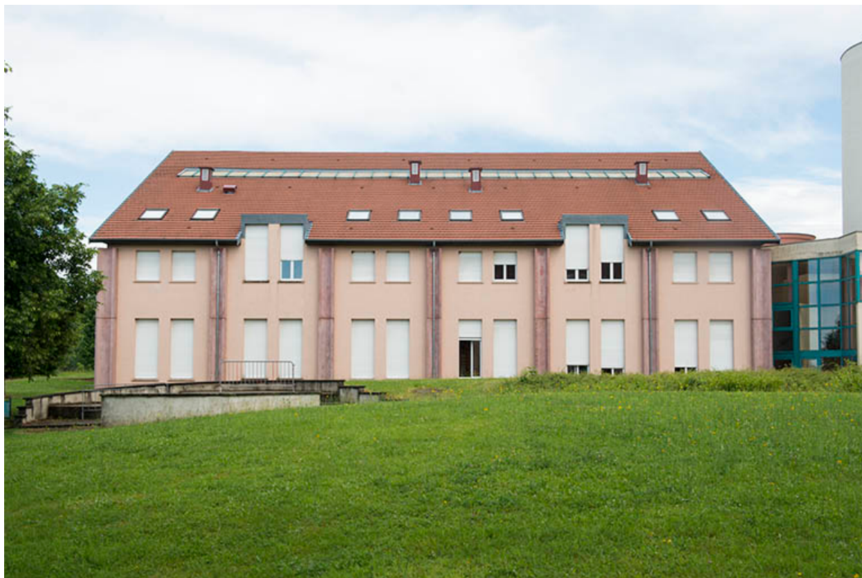
Façade antérieure sud de l'internat sud-ouest.
