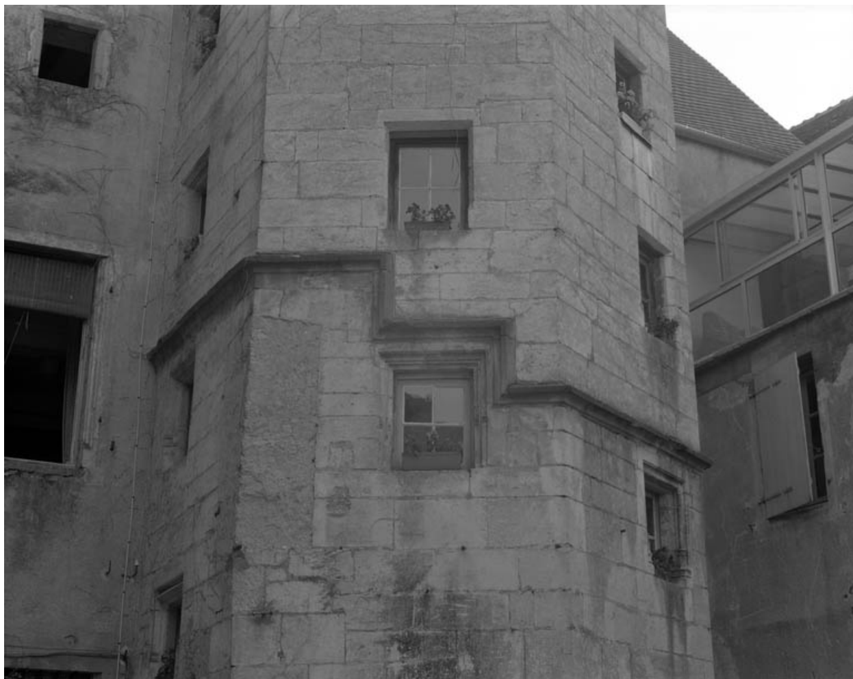
Façade postérieure. Détail : baies de l'escalier hors-oeuvre.
