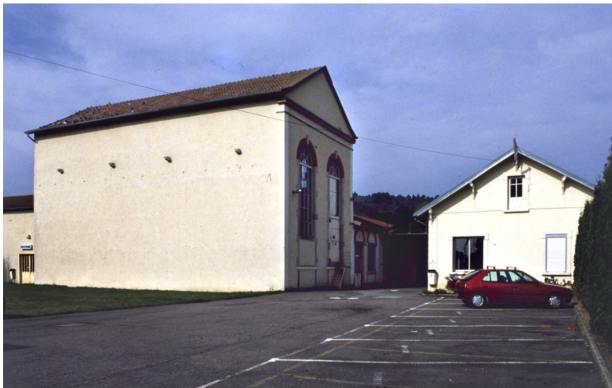
La salle des machines.
