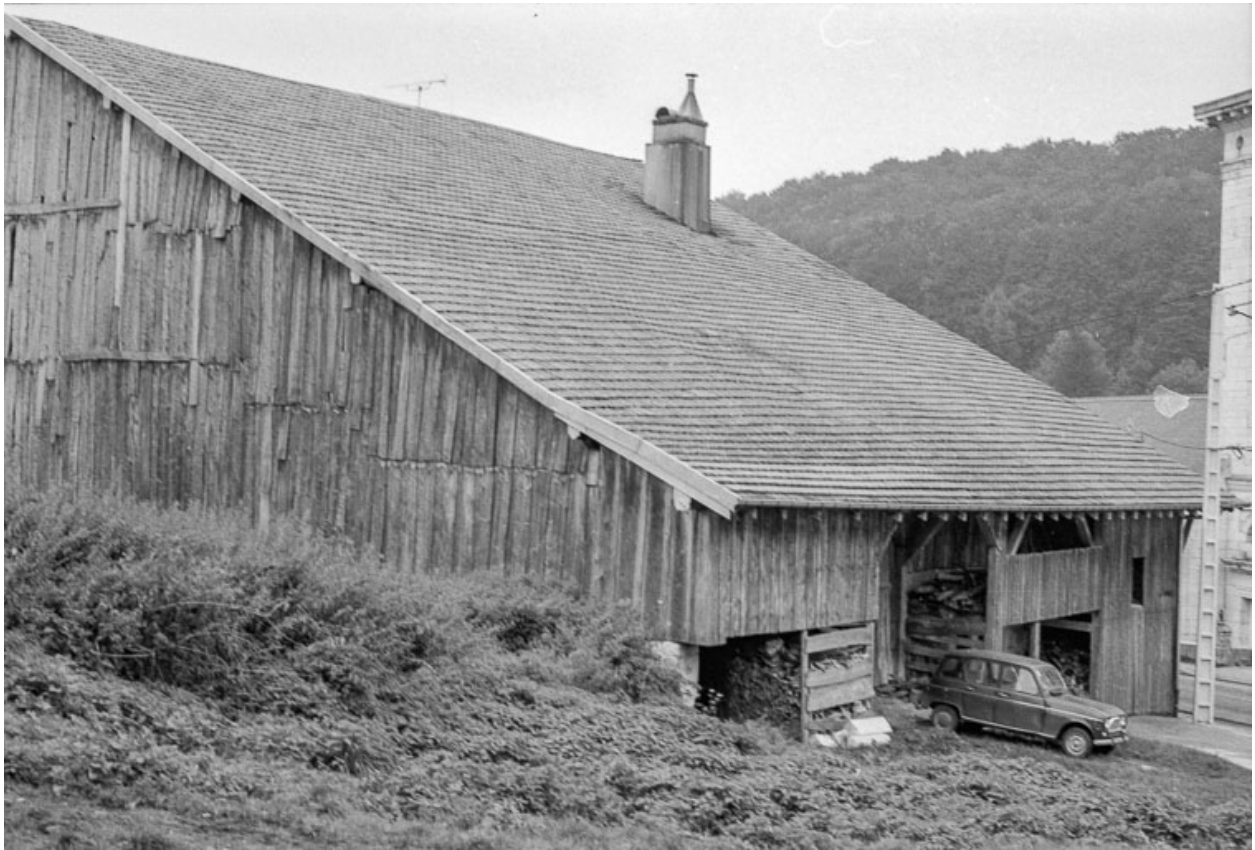
Façades postérieure et latérale gauche.
