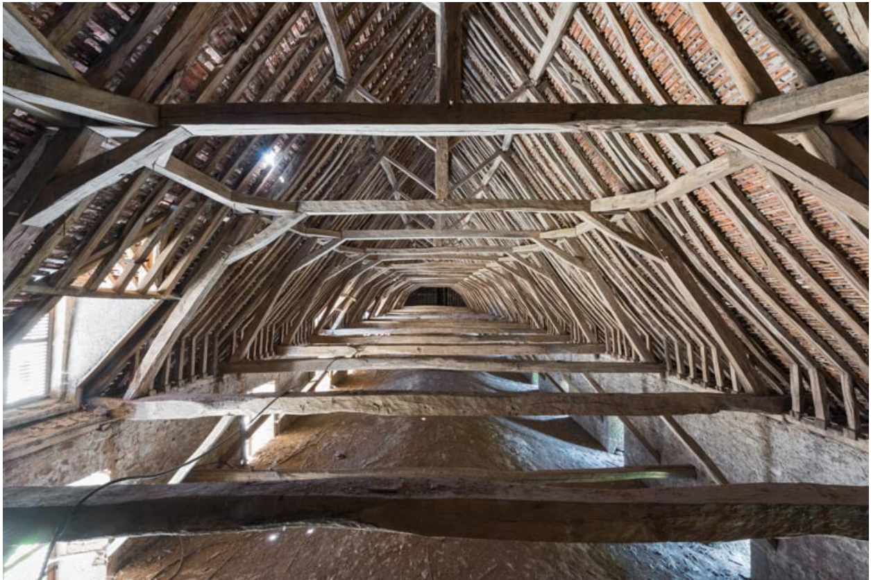
Ecurie, étage de comble : charpente.
