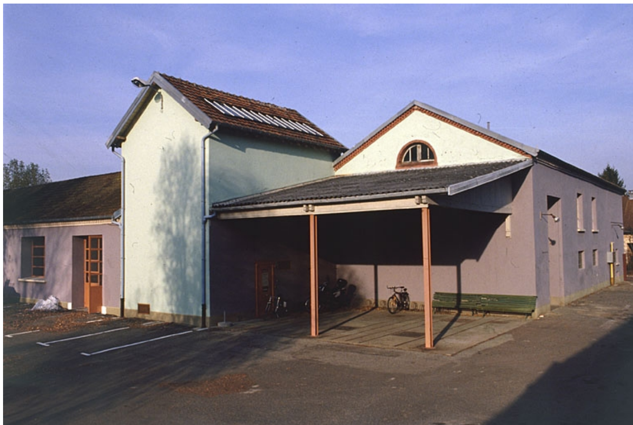
Chaufferie et atelier de forge.
