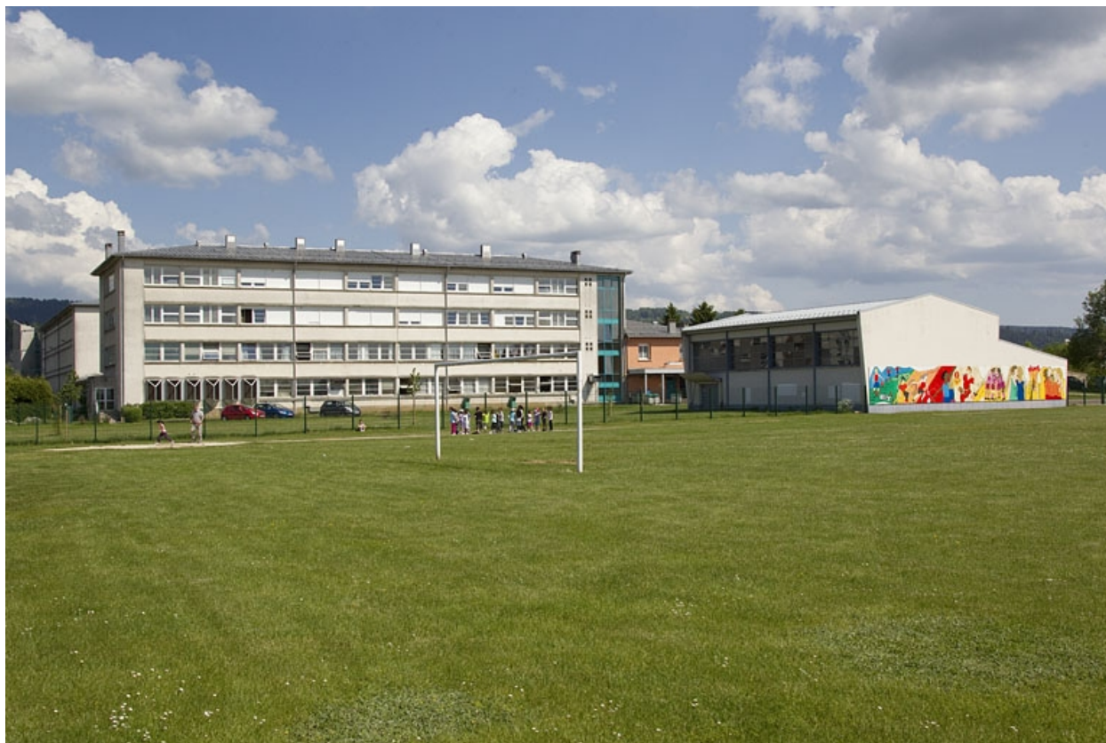
Bâtiment de l'hôtellerie et gymnase.
