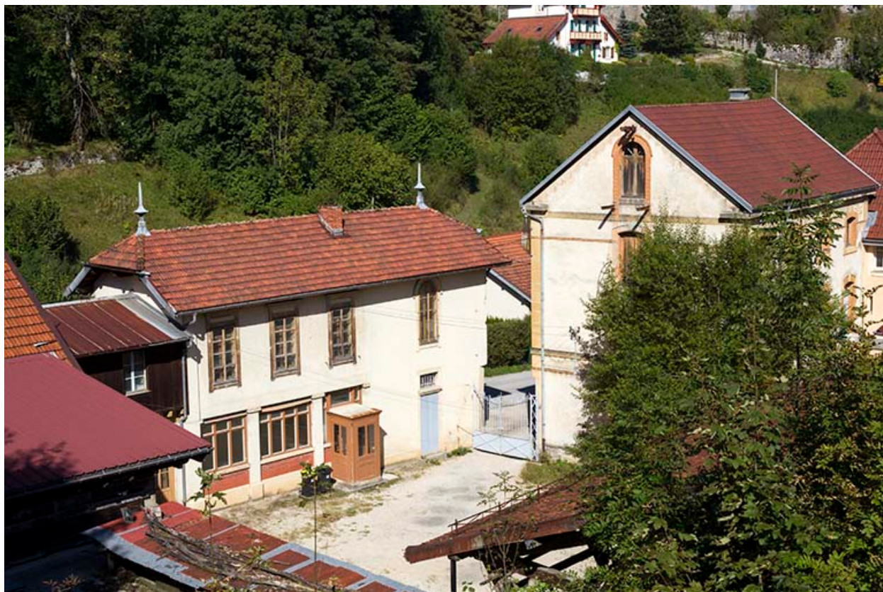
Bureau et laboratoire : façade sur cour.
