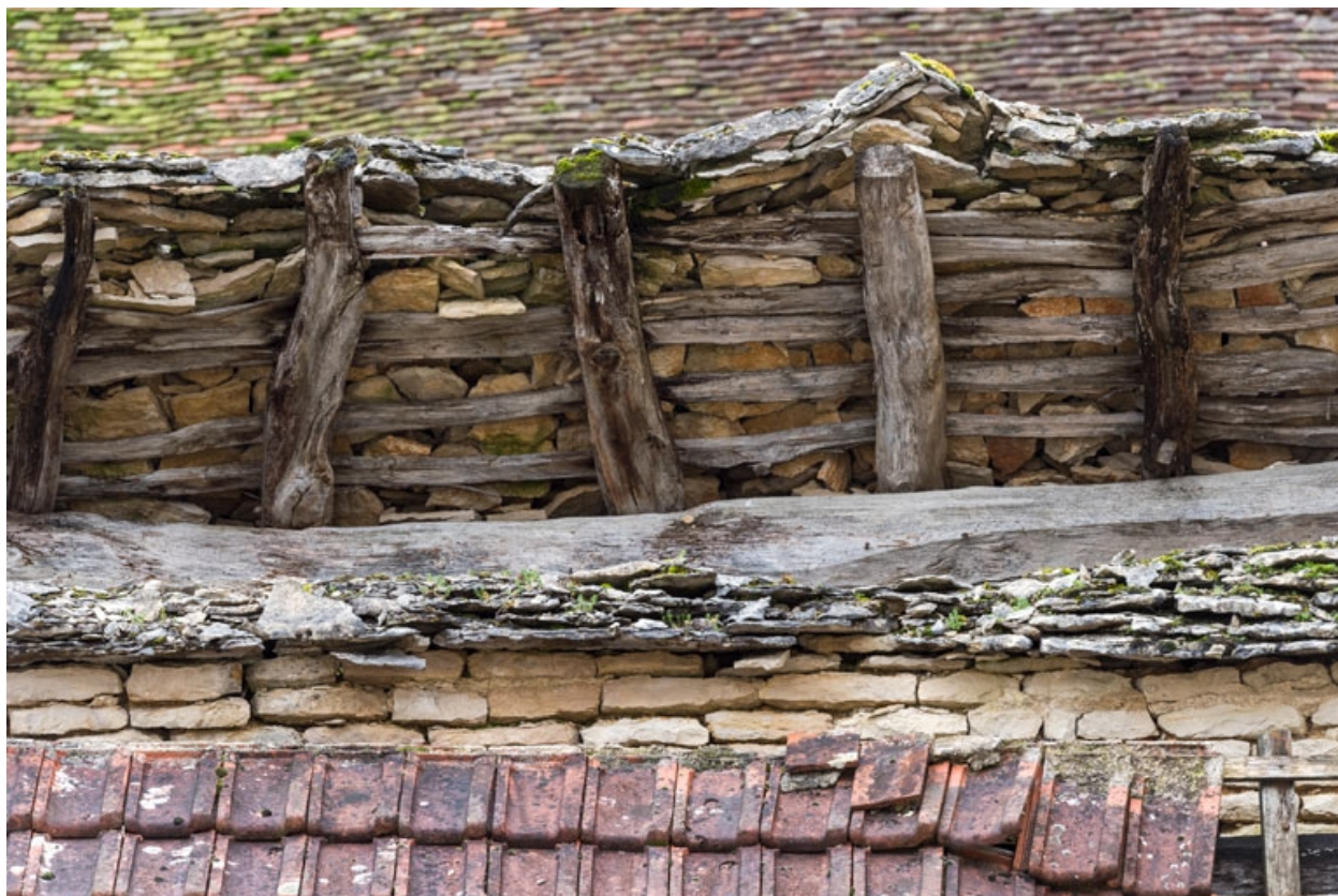
Détail de la toiture côté est.
