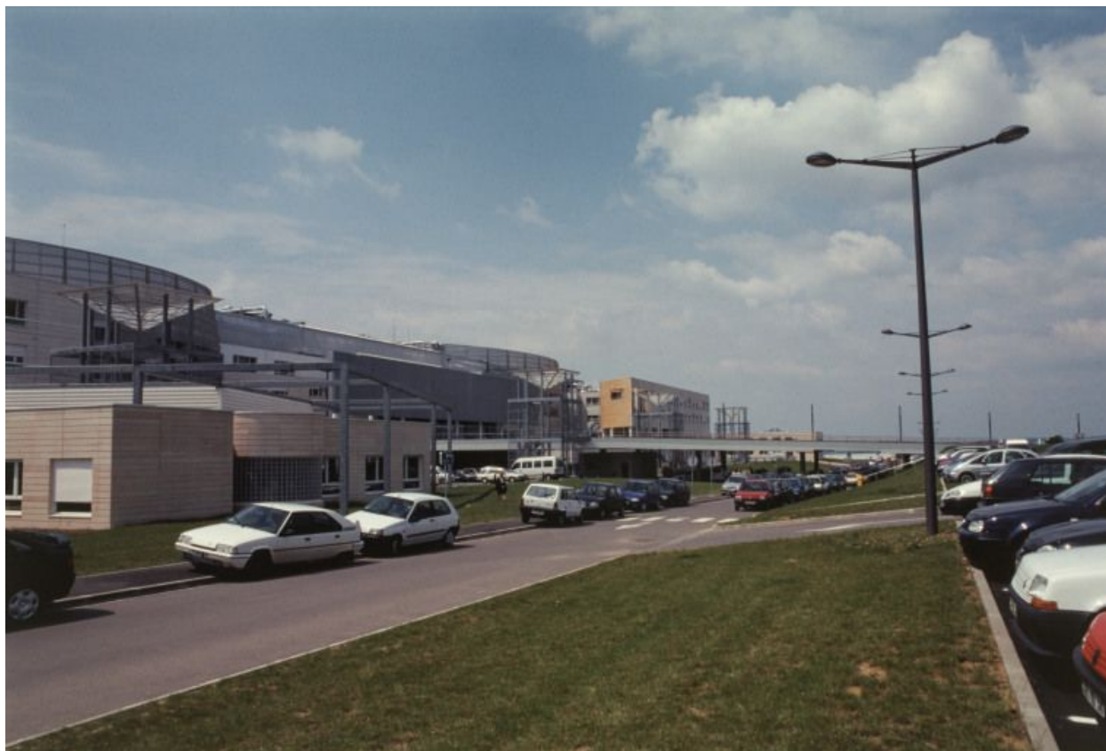
Façade antérieure, vue d'ensemble.
