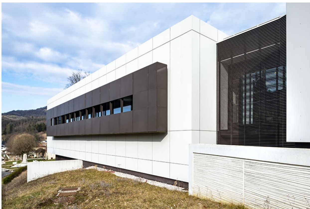
Vue depuis le sud-ouest.
