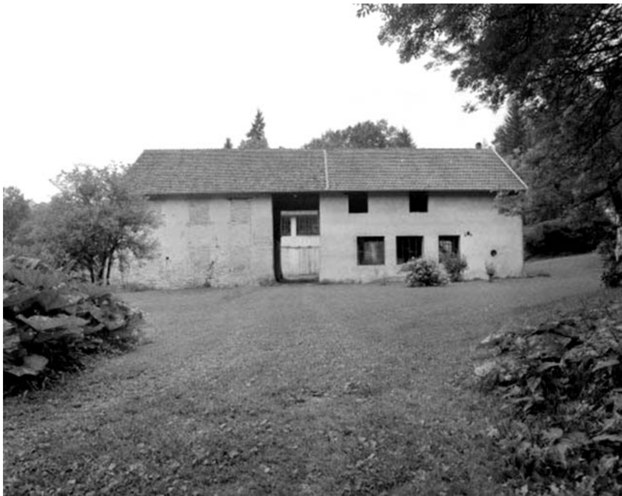
Façade postérieure de l'atelier de fabrication sud.
