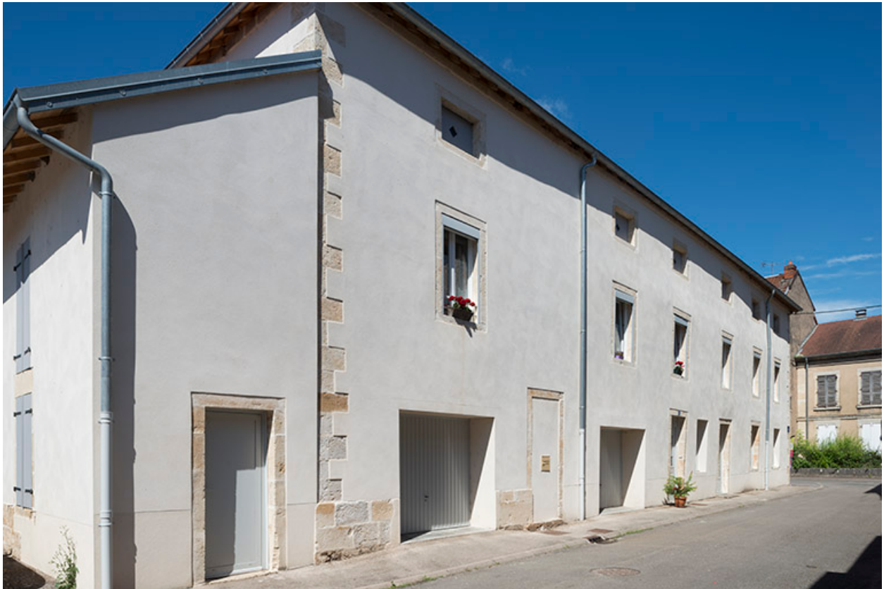
Élévation extérieure sur la rue des Forges.
