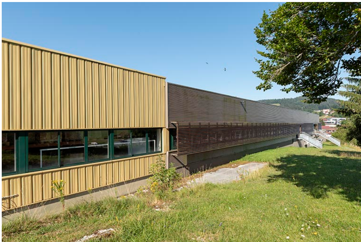
Façade postérieure, vue en enfilade.
