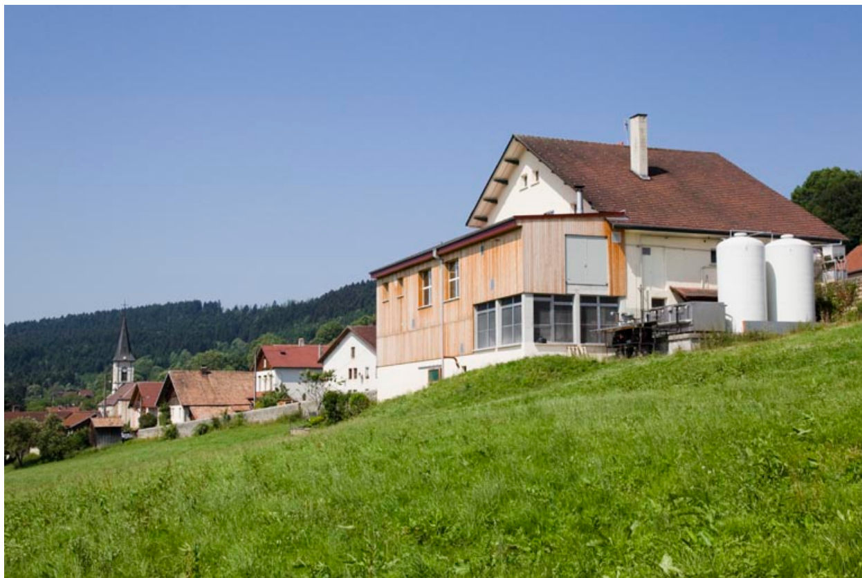
Vue d'ensemble depuis la prairie, au sud-est.
