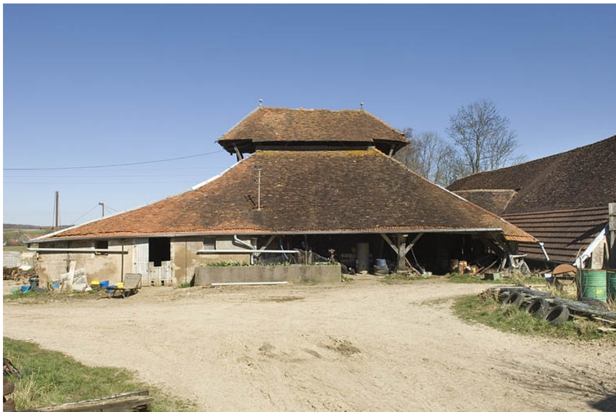
Bâtiment du four vu de face.
