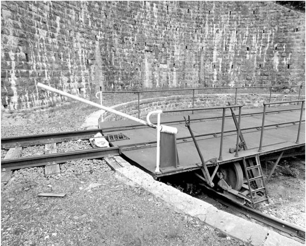
Barre permettant de faire pivoter le pont.
