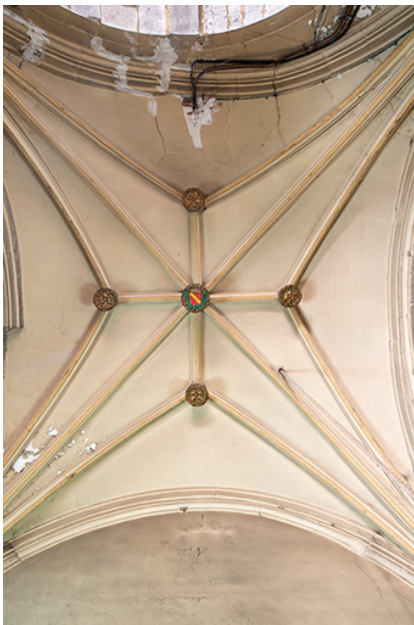
Voûtement de la chapelle axiale (et sacristie).
