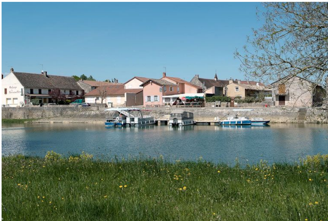
Digue protégeant La Truchère, avec port.
