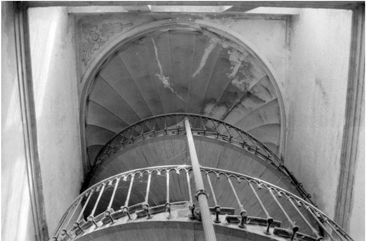
Cage de l'escalier tournant.
