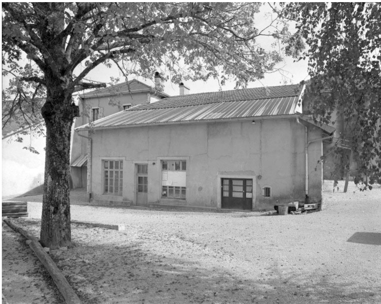
Façade postérieure du corps central.
