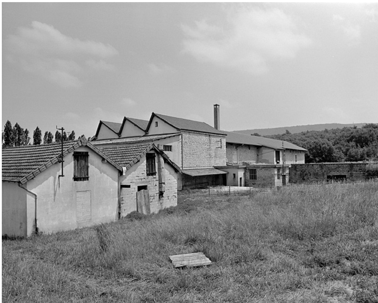
Remises et atelier de fabrication.
