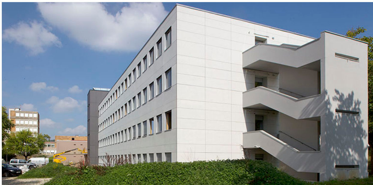
Internat : façade sud.
