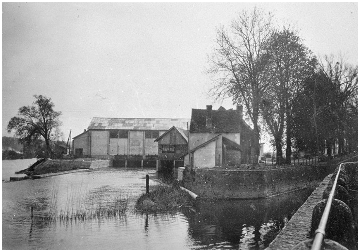
Station et moulin. Côté canal d'amenée.
