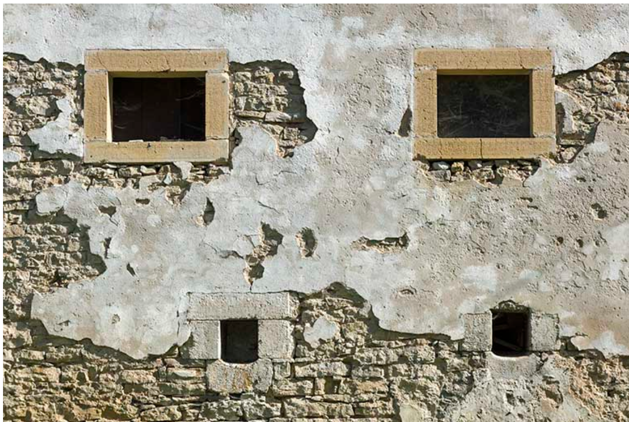
Moulin : fenêtres sur la façade ouest.
