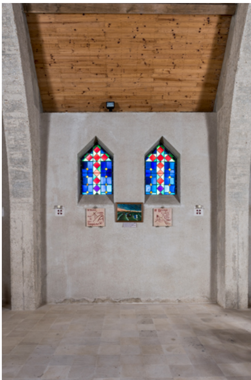
Nef, détail d'une travée.
