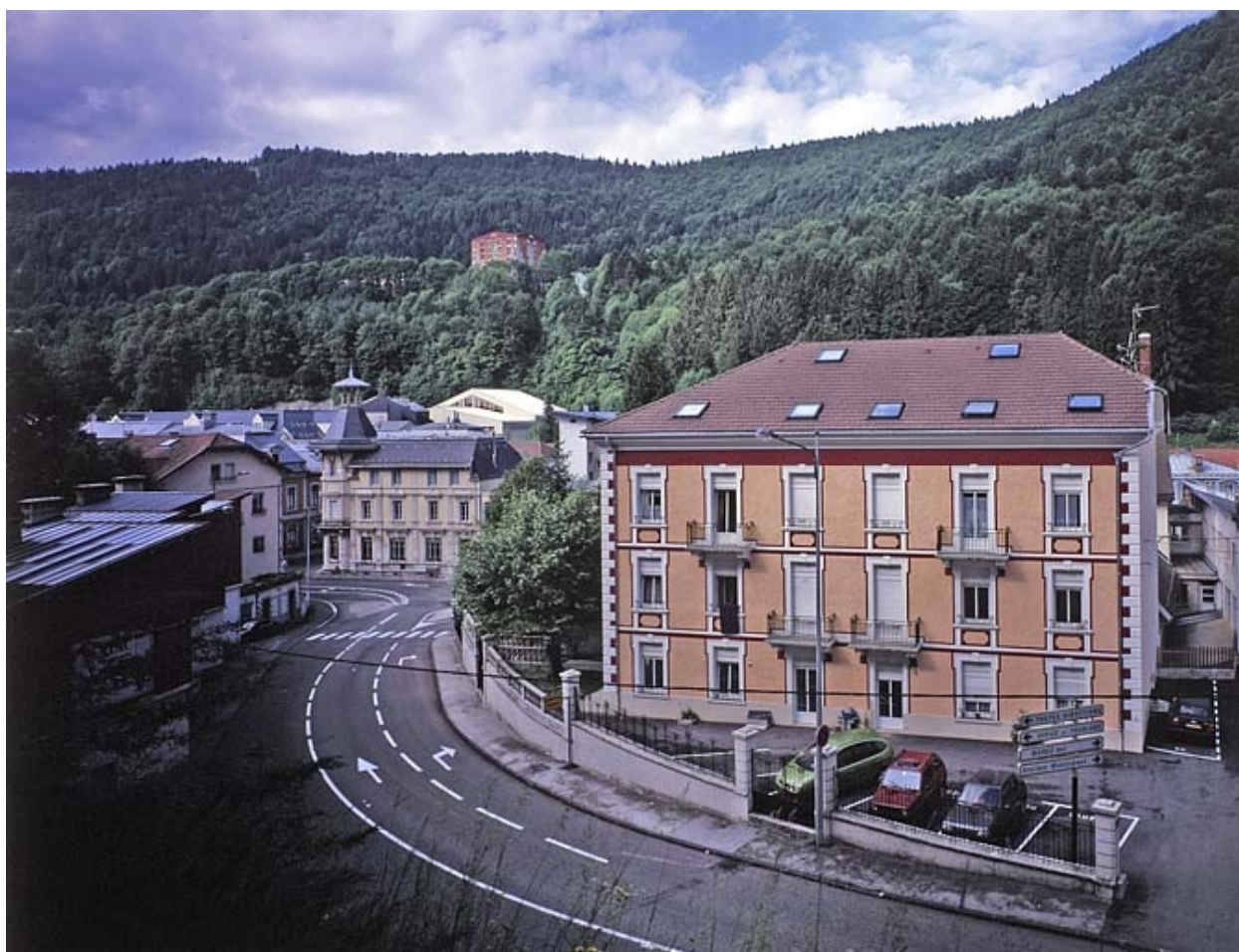
Vue d'ensemble plongeante, depuis l'est.
