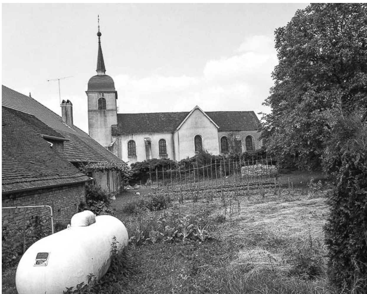
Façade latérale droite.
