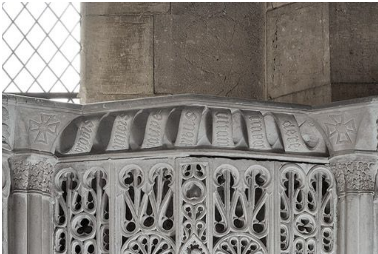
Détail du couronnement.
