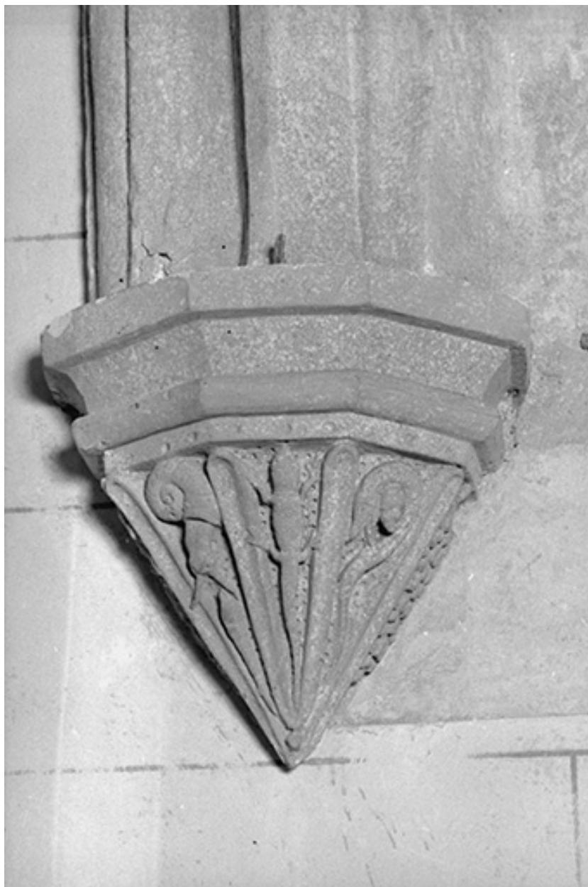
Culot. 1ère travée du chœur. Mur sud.
