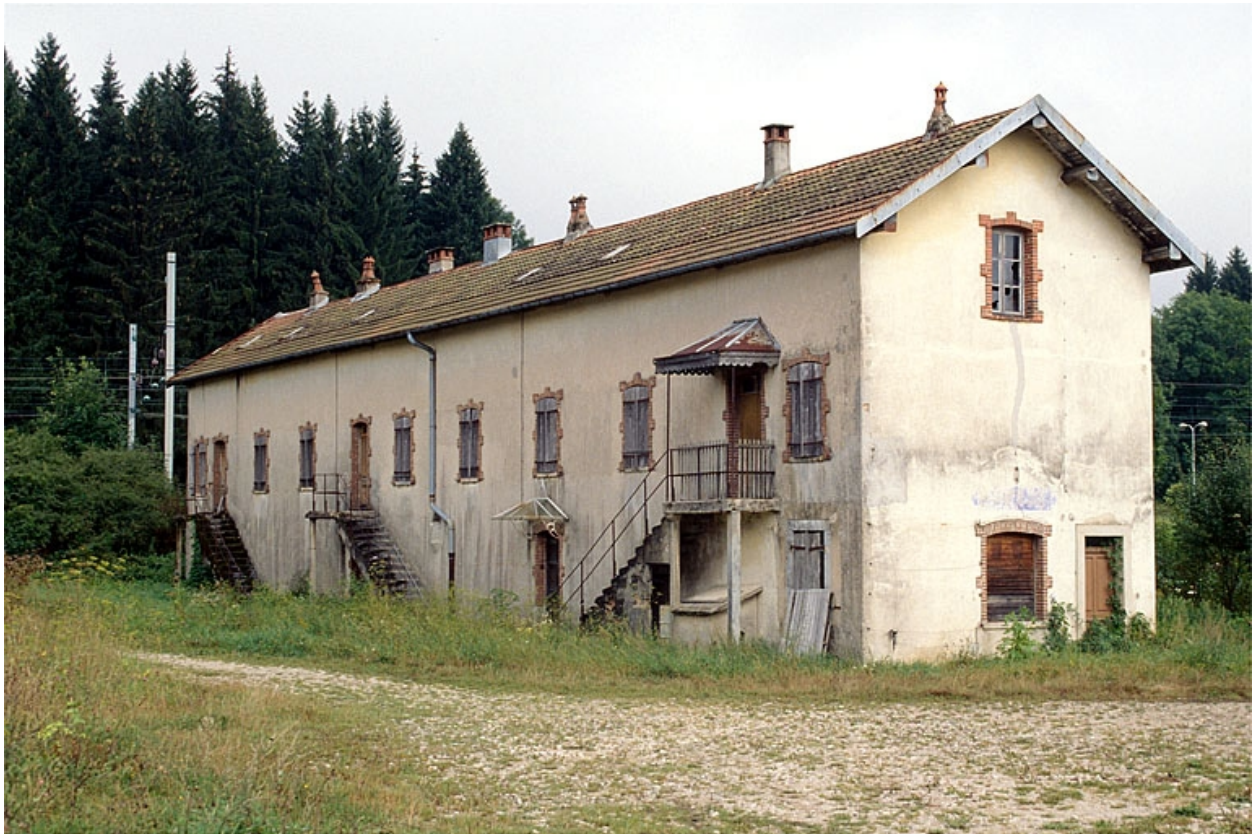
Façade antérieure du logement ouvrier.
