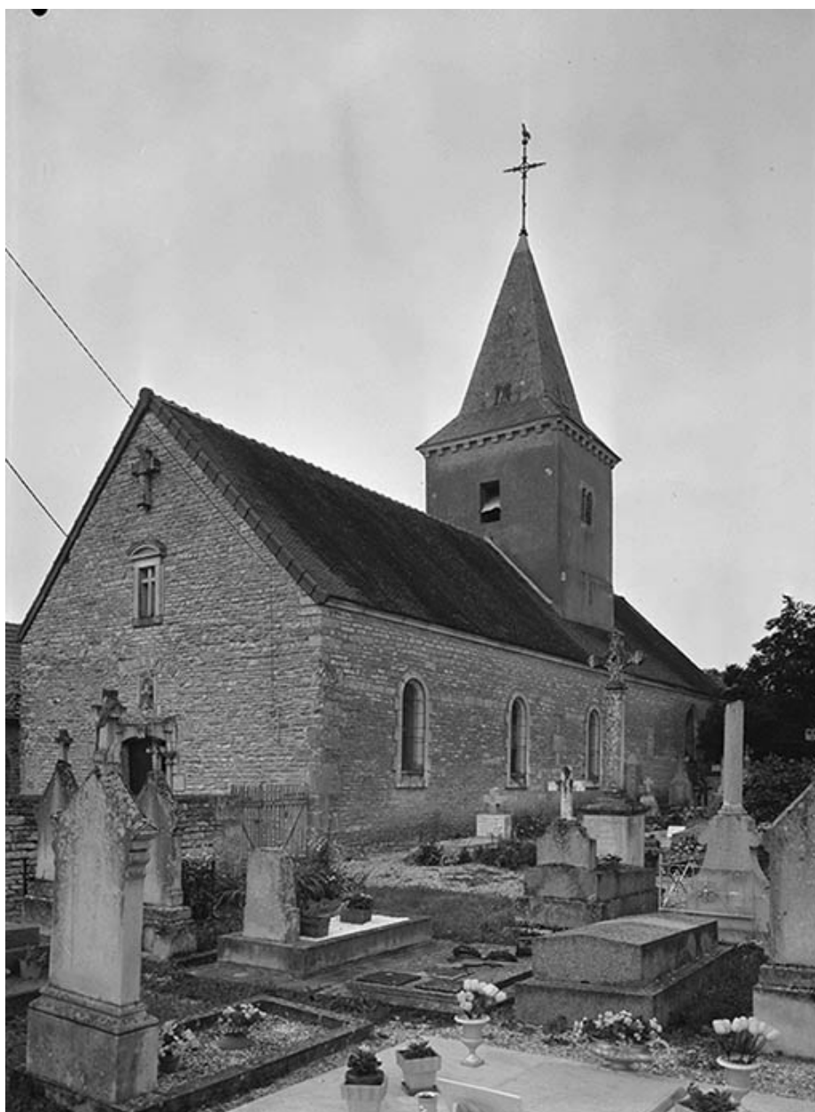
Façade occidentale et bas-côté sud.
