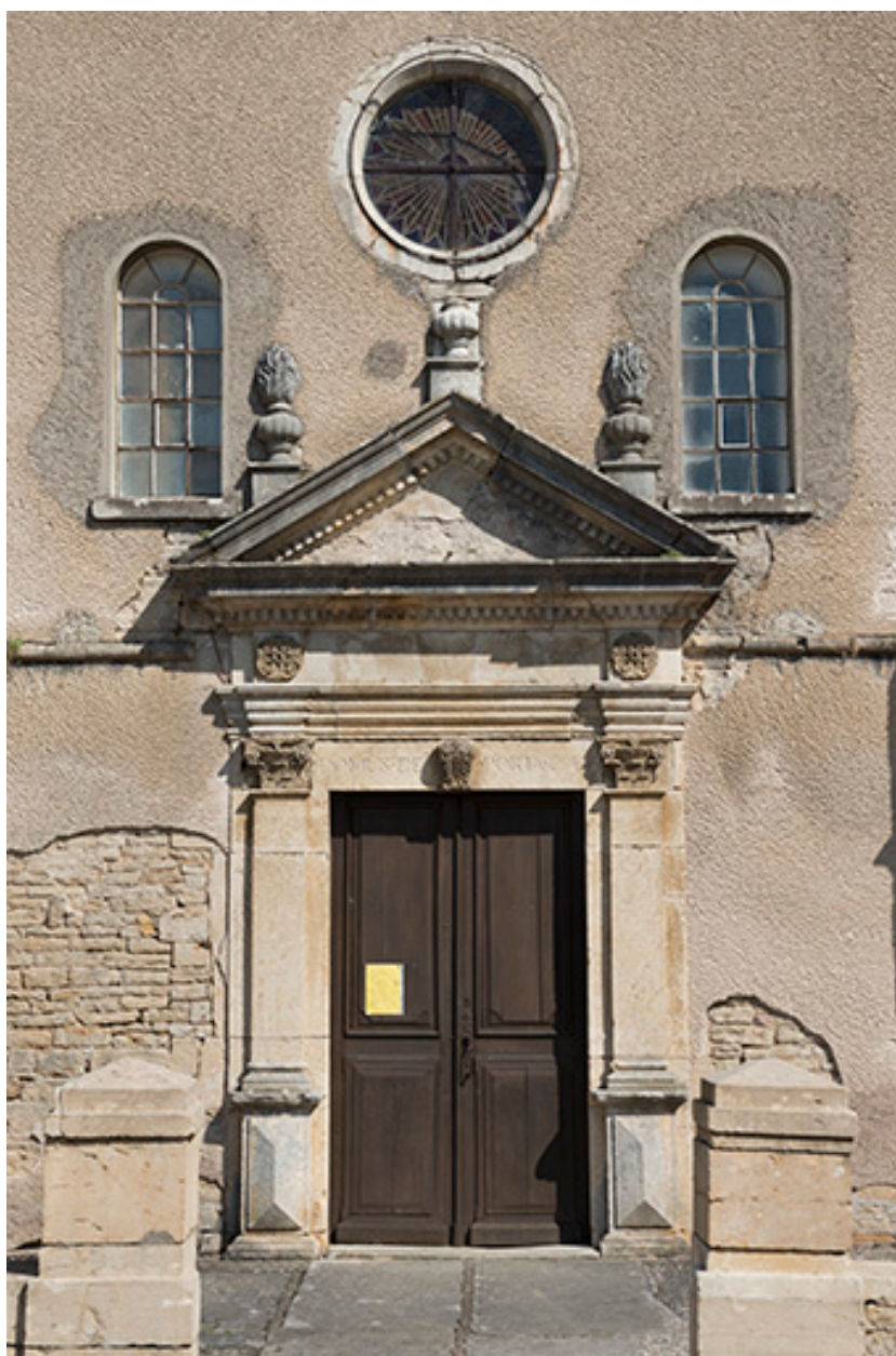
Vue avant restauration (2016).
