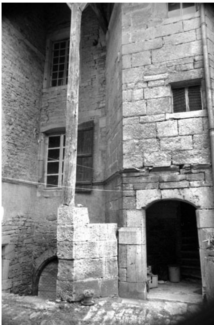
Entrée de cave et escalier en vis.
