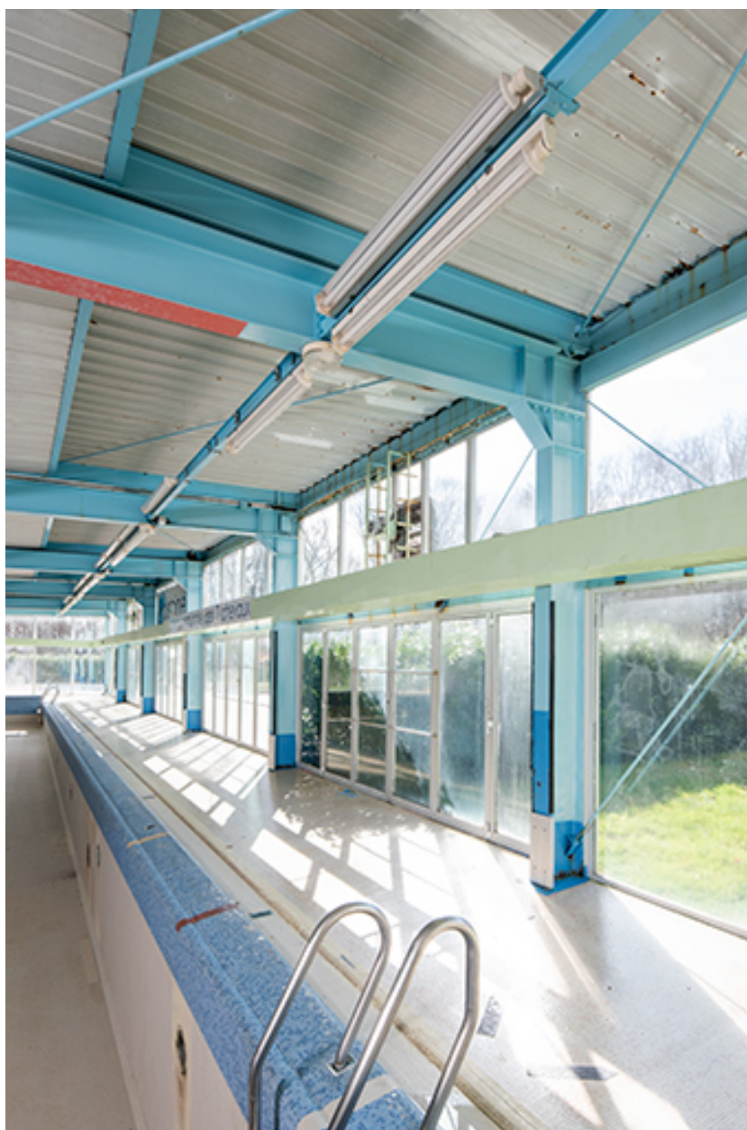
L'élévation sud-ouest de l'intérieur de la piscine, depuis le nord.
