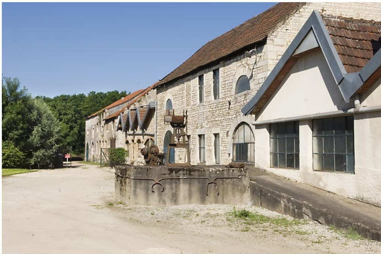
Façades sud des divers ateliers de métallurgie.
