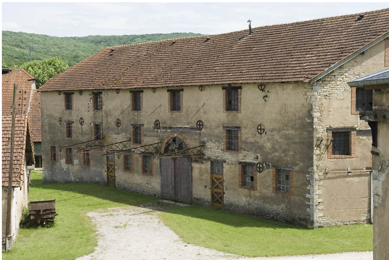
Façade ouest du magasin industriel (fonderie).
