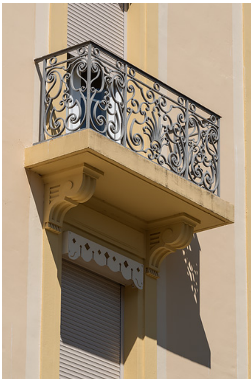
Balcon à l'extrémité est de l'aile nord.
